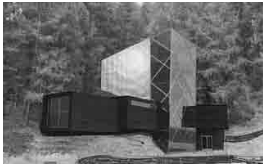
SOPRA: RENDERING DI COME SARÀ LA NUOVA STRUTTURA D'ARRAMPICATA. AL CENTRO LA TORRE CON DAVANTI LA VETRATA E LE ALTRE PARETI RIVESTITE IN ALLUMINIO PER L'ARRAMPICATA SPORTIVA; AI LATI DELLA TORRE LA SALA BOULDER, GLI SPOGLIATOI, LA SALA ACCOGLIENZA E IL BAR, COME DESCRITTO ANCHE NEL DISEGNO SOTTO (FONTE: RELAZIONE TECNICA-ILLUSTRATIVA AL PROGETTO PRELIMINARE)
